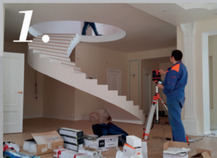
Конструктор снимает точные размеры с помощью 3D-сканера
