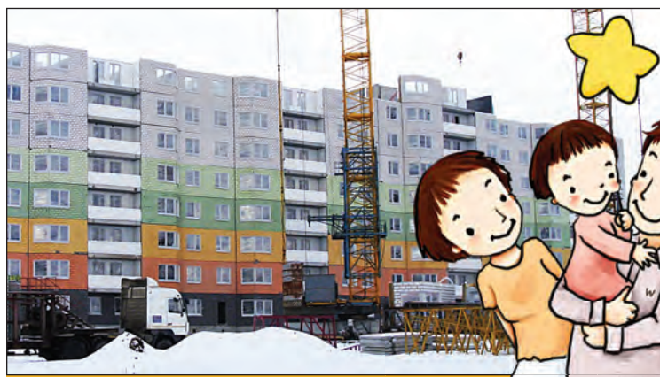
Строительство микрорайона Новая Тула идёт согласно запланированному графику.
