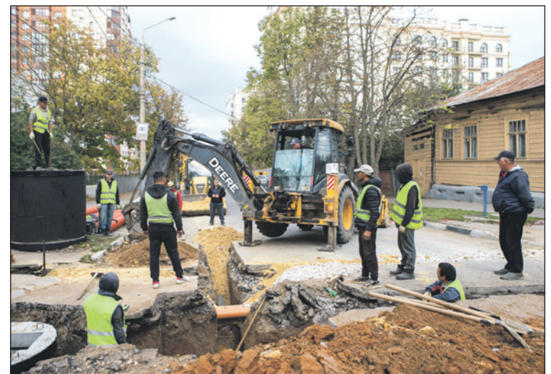
Закладывают ливнёвку на пересечении ул. Гоголевской и ул. Свободы.
