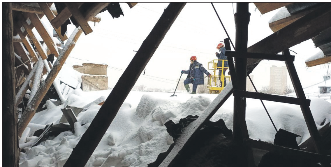
Работы по восстановлению крыши в доме на улице Р. Зорге взяла на контроль администрация Тулы.
