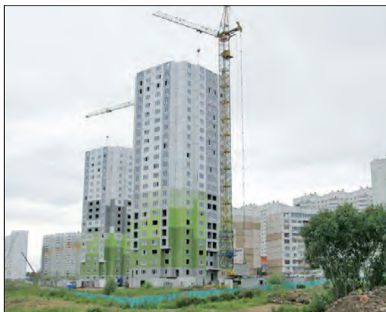
ЖК «Парус» на ул. Хворостухина в Туле. Эксплуатация СУ-155. МКД достраивают при участии АКБ «Российский капитал». Летом 2016 года введены в эксплуатацию два дома. Еще пять строят. Срок сдачи четырех – конец 2017 г., корпус №10 – 2018 г. Обманутых дольщиков 48 человек.
