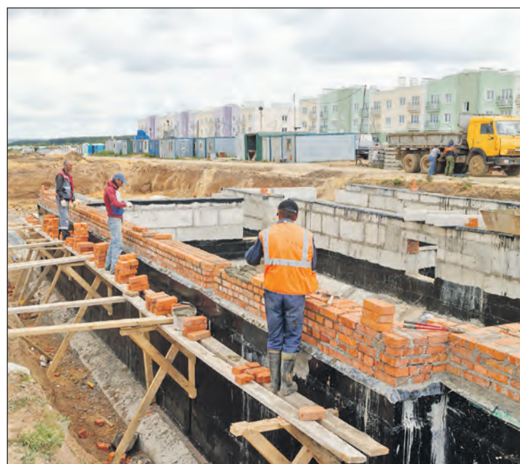
Ход строительства. Июль 2017 г.
