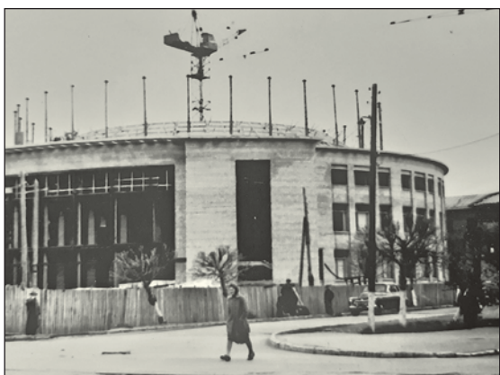
Строительство нового здания цирка.
