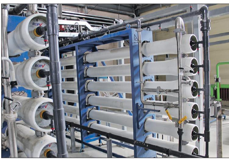
Вода в установке проходит глубокое обессоливание, очищается от примесей и поступает в котел, из которого пар подается на турбину.
