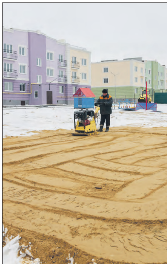
Монтаж детской площадки.
