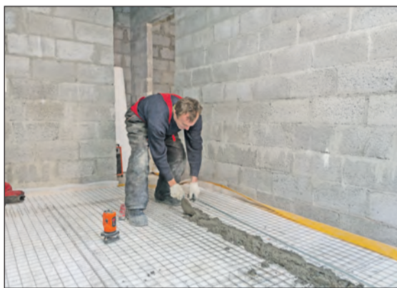
Строительство жилых домов второй очереди продолжается.
