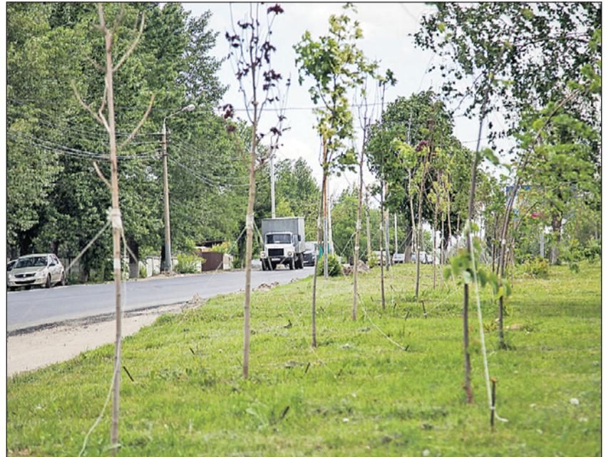
Тула, ул. Чмутова. Ремонтные работы выполнены на 90%.
