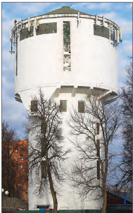
Водонапорка «головой» стоит по адресу: Тула, ул. Кирова, 161-а.
