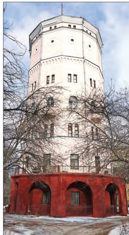
Водонапорка на улице Ак. Павлова – самый необычный жилой дом в Туле. В башне – шесть квартир. Бак с водой на верхнем этаже спустили не так давно – в 1998 году.
