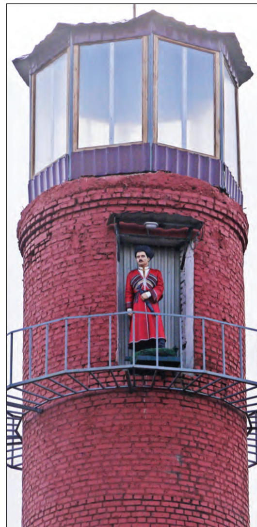
Водонапорка на станции Венёв подобна маяку: её верхушку венчает большой фонарь, мерцающий ночью, а на площадке несёт службу бравый смотритель.
