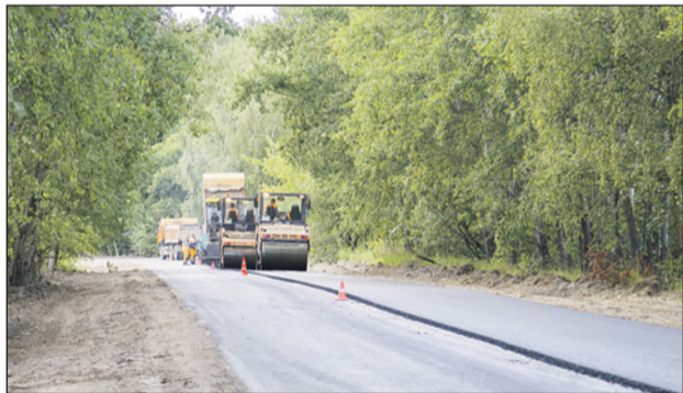
В 2018 г. по проекту «Безопасные качественные дороги» отремонтированы 88 автодорог протяженностью 120 км.
