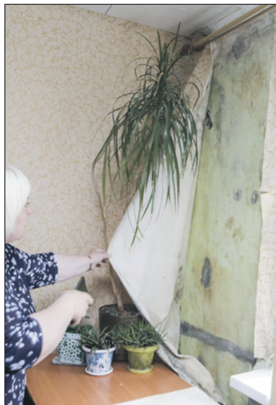
Сырость и плесень в квартирах барака из-за протекающей крыши.
