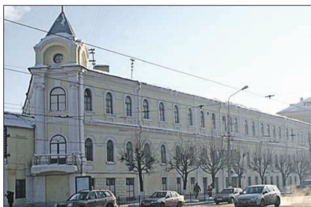
Сейчас в этом здании располагается прокуратура Центрального района.
