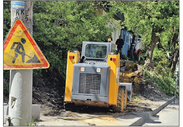
На ул. Арсенальной сложный рельеф. Для безопасности жителей здесь появится лестничный марш.
