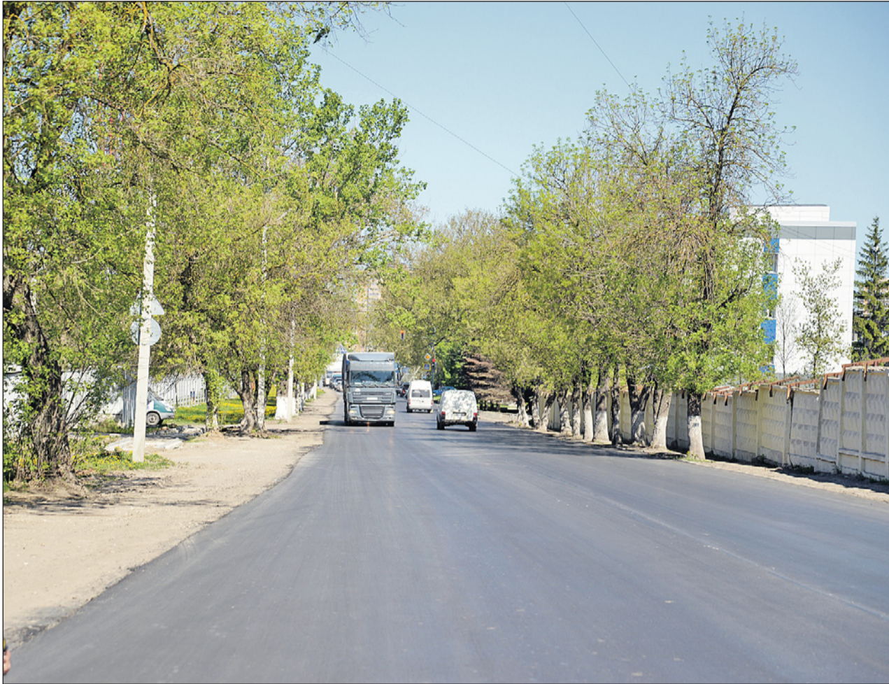
Чтобы днем не создавать пробки на загруженной улице Скуратовской, ремонт дорожного полотна производится только в ночные часы. Уже выполнено 20% запланированных работ.
