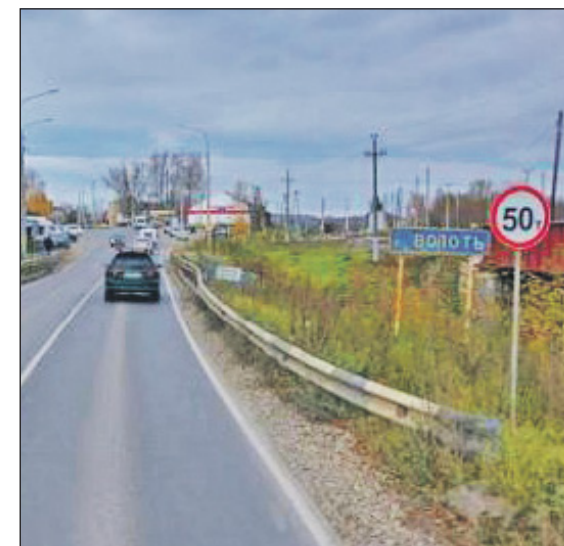
Ограничение вводят в связи с обследованием моста.
