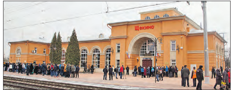
Обновлённое здание железнодорожной станции Щёкино – светлое, стильное и современное.
