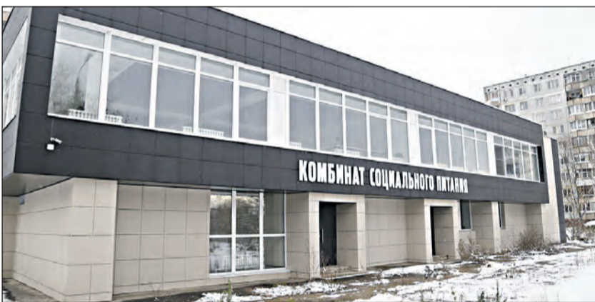
Тула, ул. Луначарского, 67. ТД СПП реконструировал здание для размещения в нём комбината питания.
