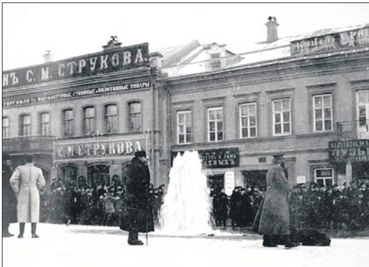
Прорыв водопровода на Киевской улице.
