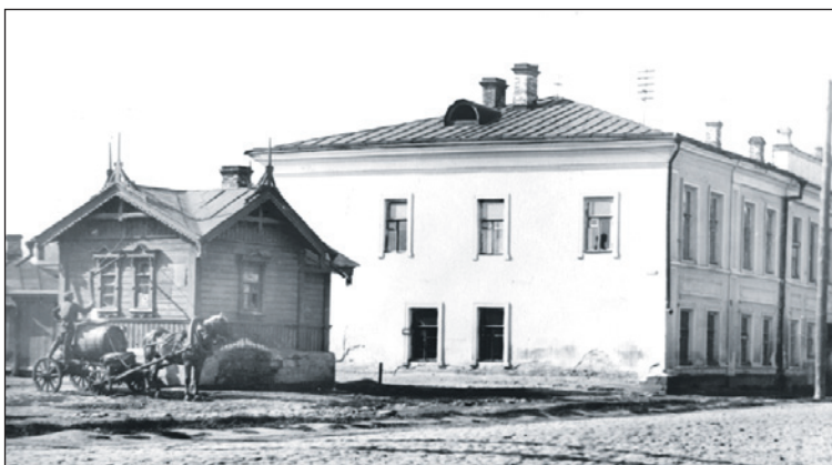
В первый год эксплуатации вода в водозаборных будках была мутной и плохо пахла.
