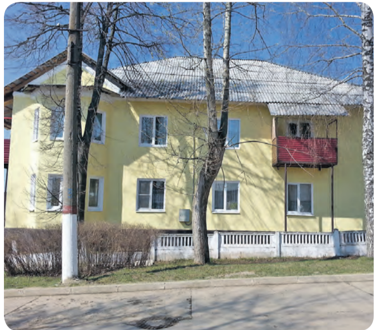
П. Шатск, ул. Садовая, 4. Вот так выглядят дома «Комсервиса» после капремонта.
