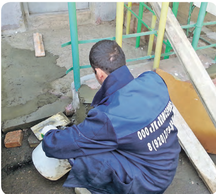
П. Шатск, ул. Садовая, 9-а. Весенние работы по восстановлению порогов при входе в подвезд.
