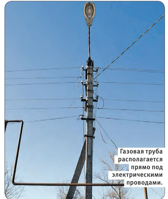
Газовая труба располагается прямо под электрическими проводами.
