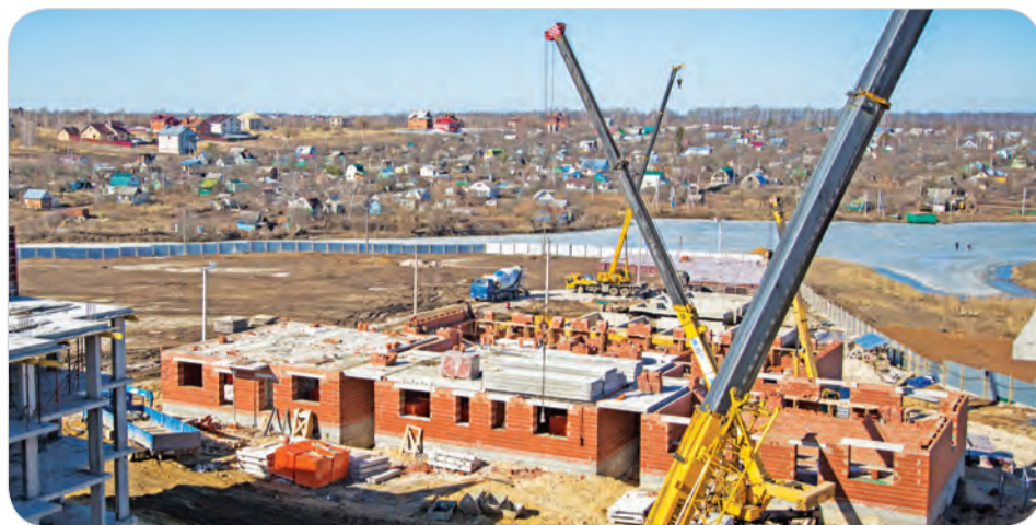
Пятиэтажки, таунхаусы и форплексы возводятся одновременно. Ни один дом не простаивает.
