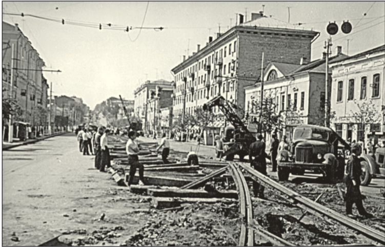
Снятие трамвайных рельсов на улице Коммунаров (ныне проспект Ленина). Фото Альберта Зорина.
