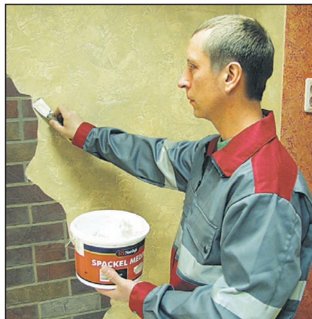
Отделка стен венецианской штукатуркой - настоящее искусство, индивидуальная авторская работа.
