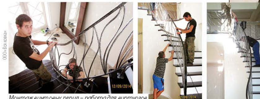
Монтаж винтовых перил – работа для виртуозов.
