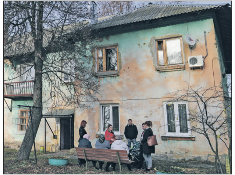
Жители дома №6 по ул. Заводской в Щекино: «Соседние дома ремонтируют, а наш почему-то нет».
