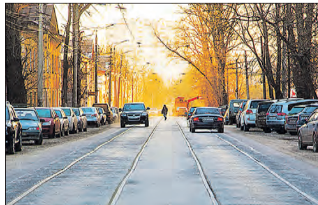
Трамвайные пути на ул. Михеева в Туле отремонтированы по финской технологии.
