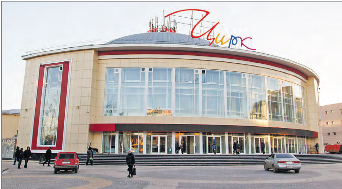
Новыми красками заиграл привычный фасад здания Тульского цирка.
