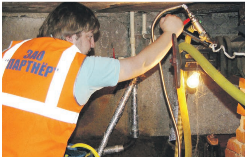
ЗАО «Партнер» проводит промывку труб систем отопления с помощью новой технологии с использованием специальных реагентов.
