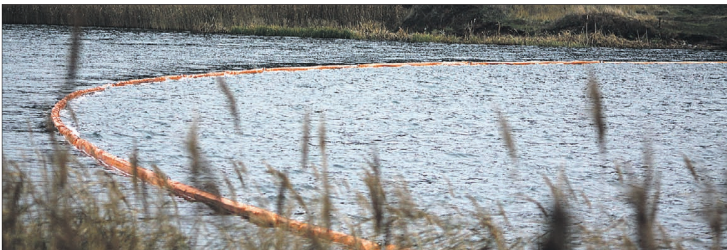
Ликвидаторам аварии пришлось в нескольких местах перекрыть реку с помощью боновых заграждений общей длиной более 2 км!
