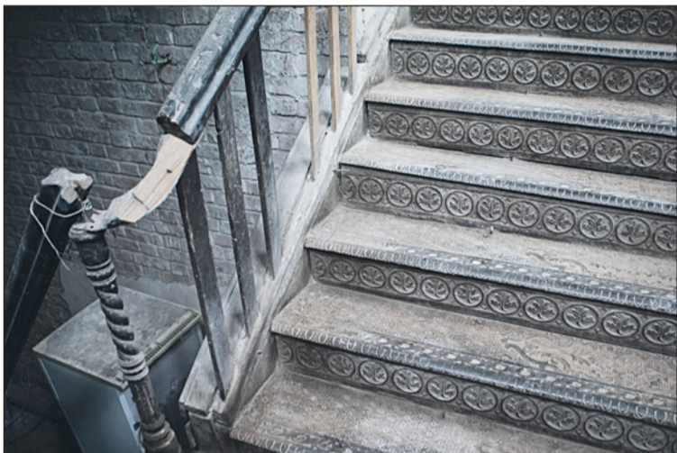
Чугунная лестница в доме Мосоловых сохранилась в очень хорошем состоянии.
