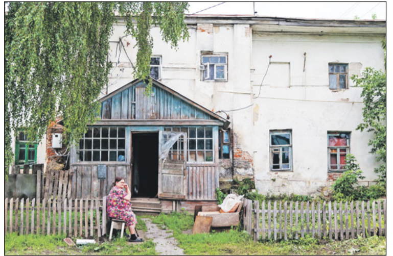
Дом прачечной усадьбы Мосоловых. Пока жилой и не расселен. К реставрации объекта приступят после сдачи дома Мосоловых.
