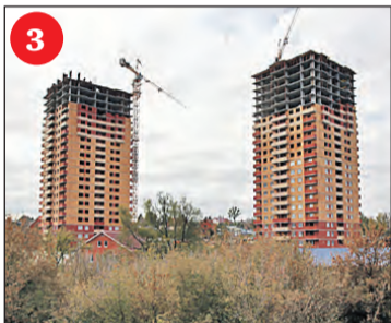
ЖК «Парковый», ООО «Стройкомплект». От 43 610 руб.
