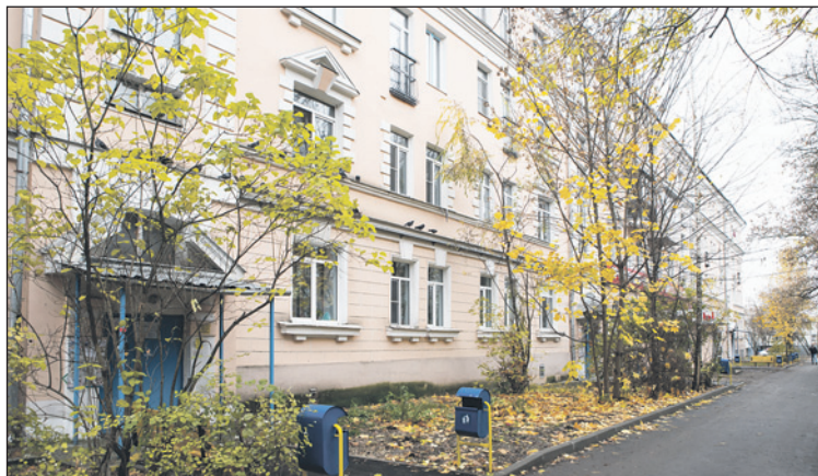
Дом №161 по ул. Кирова в Туле. Капитально отремонтирован в 2022 г.
