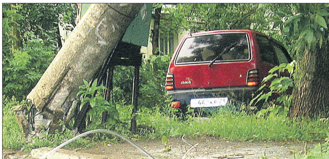
14 июля, двор на ул. Мира, 15. Столб линии электропередач едва не свалился на «Оку», стоявшую рядом с ним.
