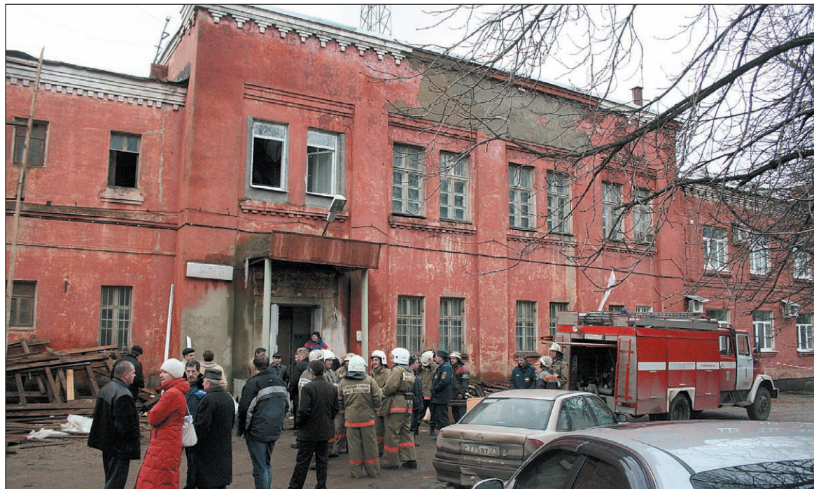
Тула, ул. Тимирязева. Последствия аварии на подстанции «Перекоп» были устранены в течение полутора часов.
