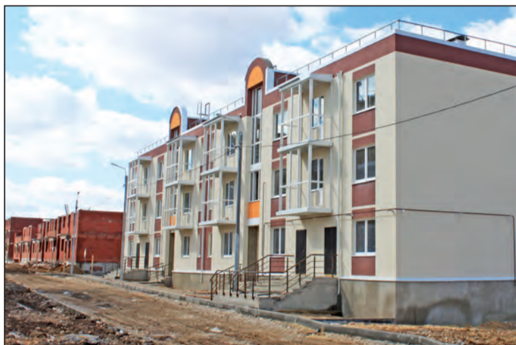
В Петровском квартале строятся 5- и 9-этажные дома, а также новый вид жилья – форплексы. И на них тоже будет действовать скидка!
