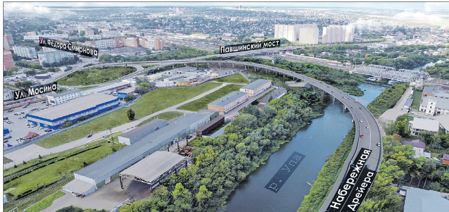
Мост соединит три района: Зареченский, Советский и Привокзальный, что облегчит транспортный поток и избавит Тулу от пробок.
