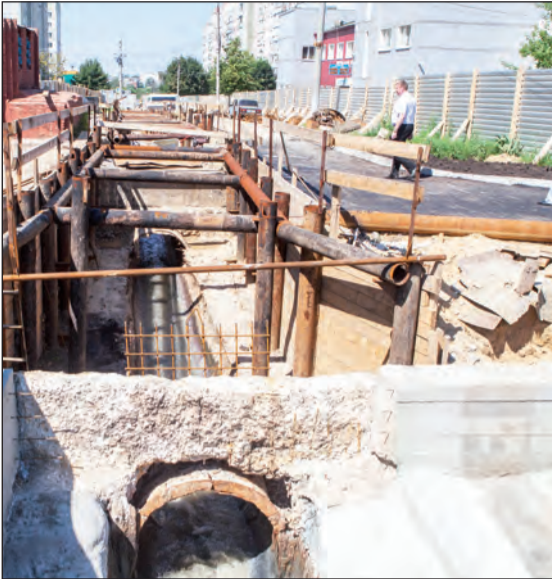
Ремонт канализации на ул. Степанова и Чапаева продлится до 1 октября.
