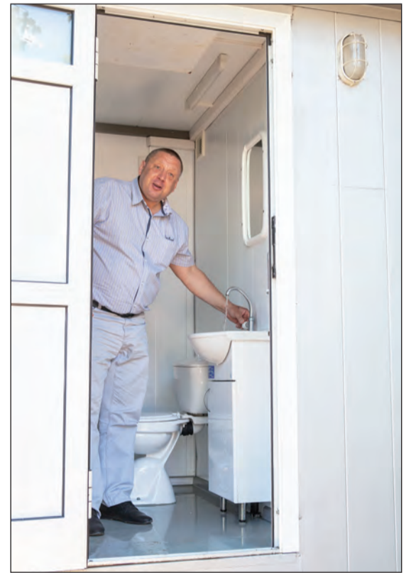
В сквере у Щегловского монастыря почти закончен монтаж общественного туалета.
