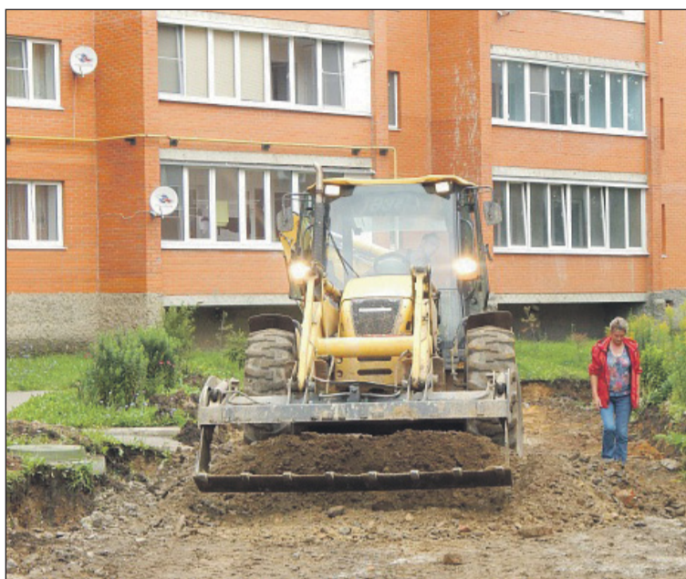
Работы по асфальтированию придомовой территории дома №9-а (корпус 2) по Ясенковскому проезду в городе Щекино в рамках «Народного бюджета – 2018».
