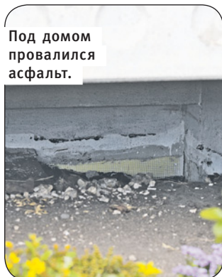
Облицовочный кирпич разрушается.
