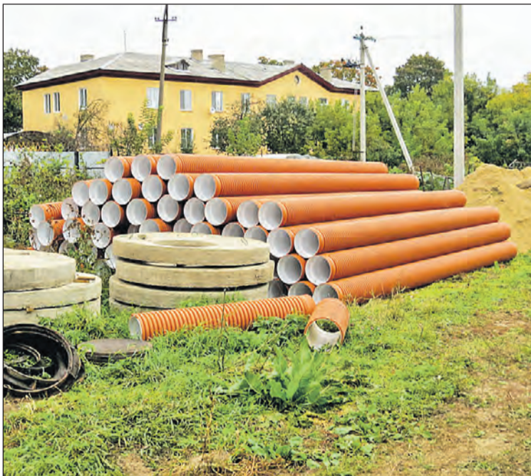
Старые трубы ливневой канализации в посёлке Барсуки были изношены на 90%. До конца сентября на их месте появятся новые.
