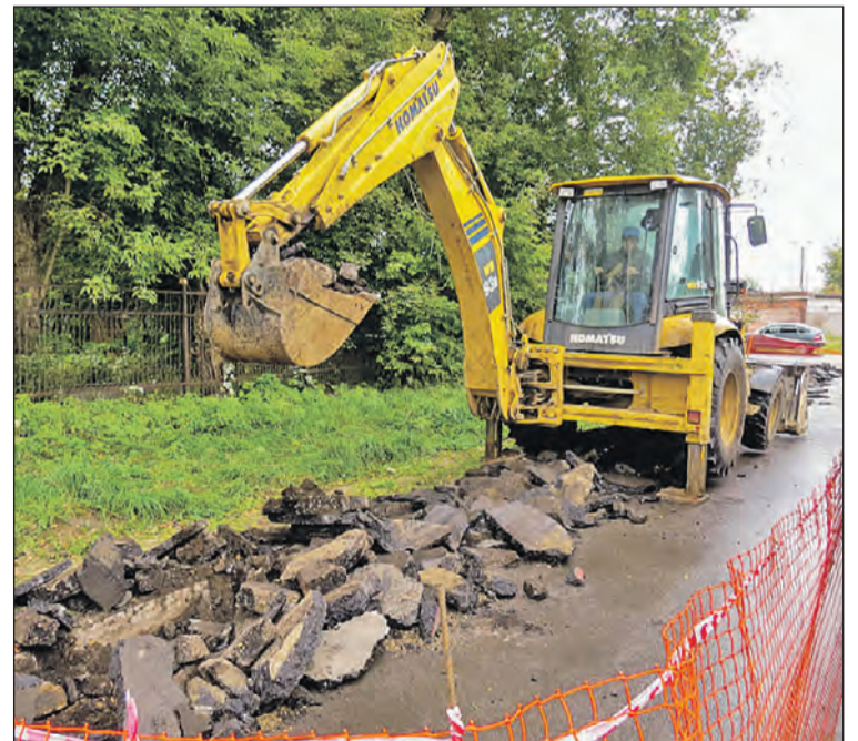
Пересечение ул. Академика Бардина и ул. Metallургов постоянно затопляло после дождей. Теперь здесь появятся новые ливневки.
