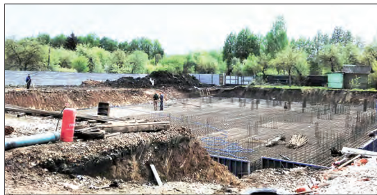
Строительство идет с конца апреля 2017 года. Залит фундамент, начинается монтаж этажей. Дом планируют сдать в 2018 году.
