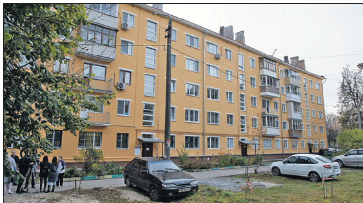
Тула, ул. Н. Руднева, 60. По программе капремонта здесь отремонтировали фасад и крышу, заменили электропроводку и окна в подъезде.
