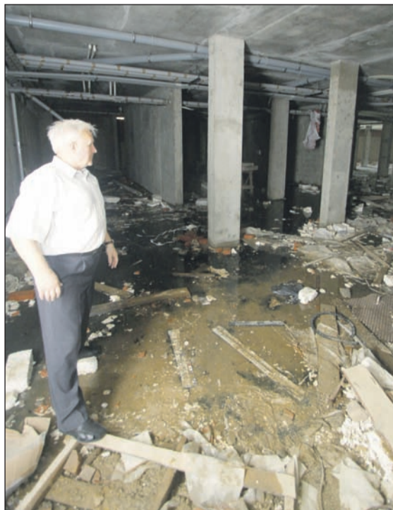
Вячеслав Чирков: «Вот наш подвал: его постоянно заливают грунтовыми водами».
