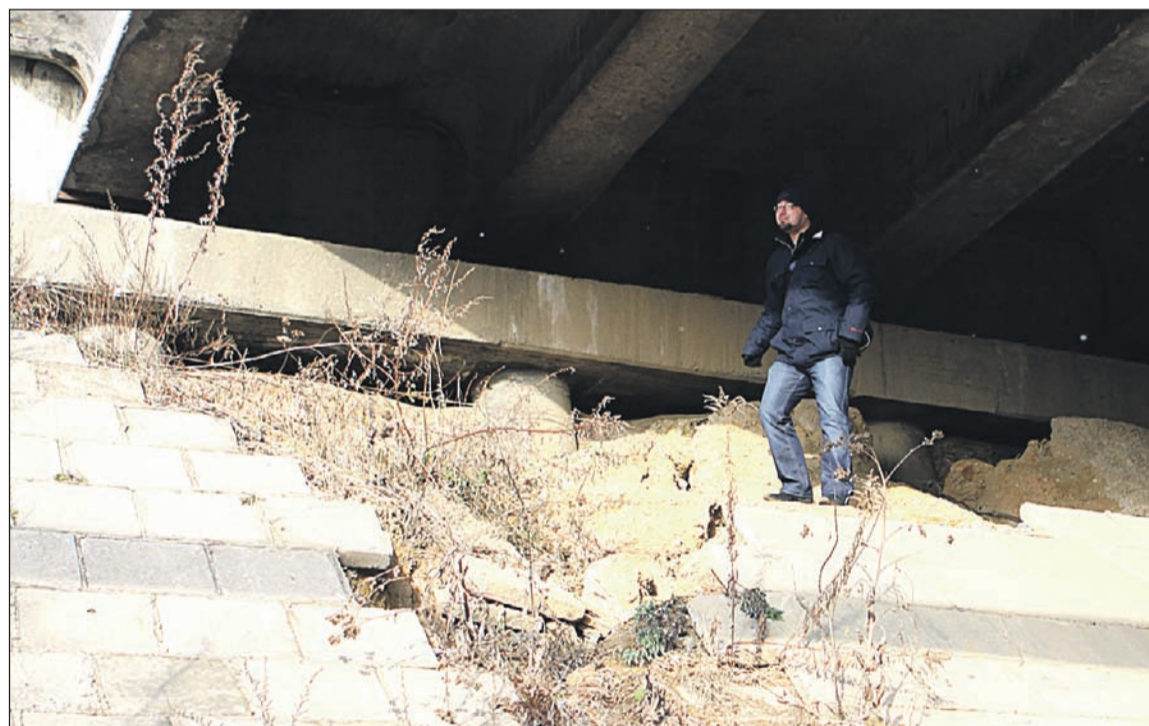
18 ноября 2011 г. Павшинский мост. У основания моста – огромная трещина в человеческий рост: опору моста размыло водой.
