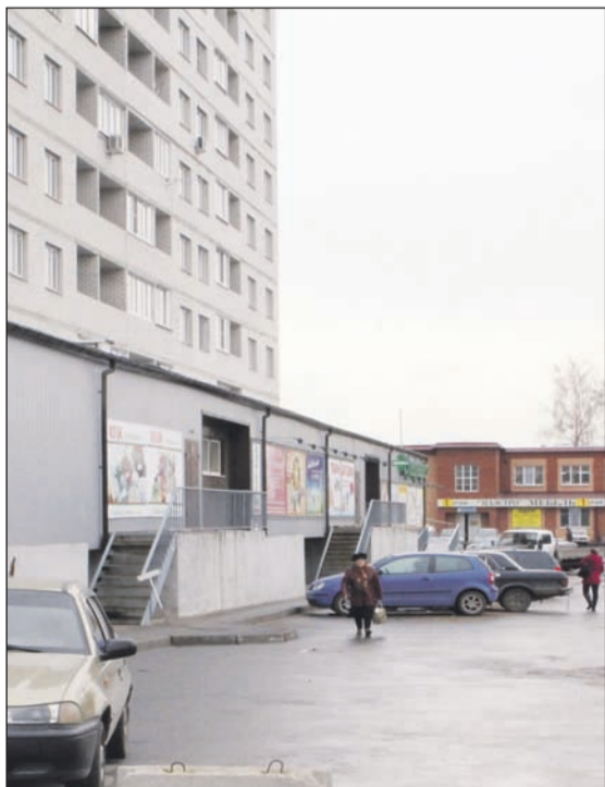
От магазинов, которые находятся на первом этаже новостройки, идет постоянный шум.
