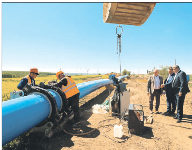
В Туле в прошлом году начались работы по обновлению сетей водоводов.
