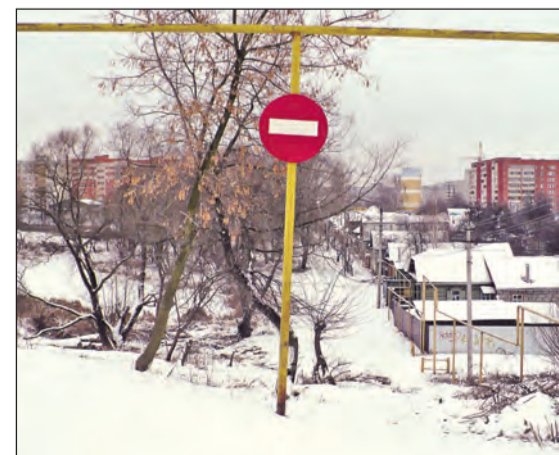
Проезд в трубу запрещён! (Фото Сергея Киреева, Тула).
