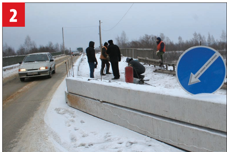
15 января 2008 г. Мост в районе дер. Мыза.
