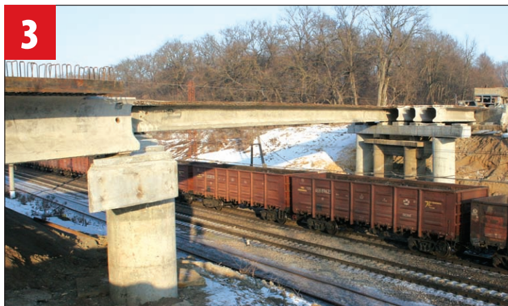
15 января 2008 г. Косогорский путепровод.
