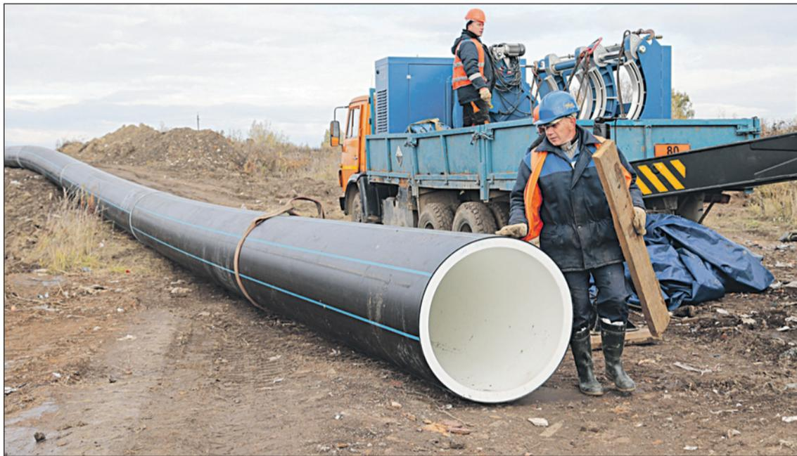
Работы ведутся по графику. Уже уложена водопроводная труба протяженностью более 3000 метров.
