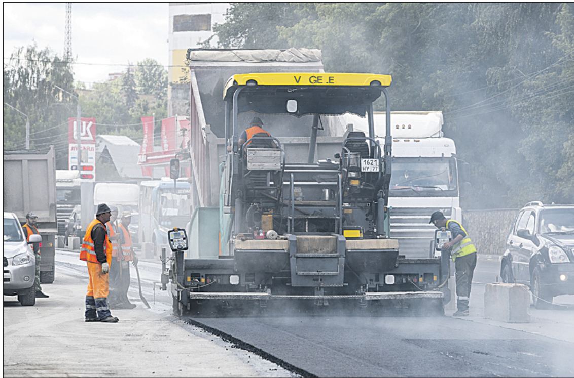
Ремонт улицы Рязанской в Туле завершится к сентябрю.
