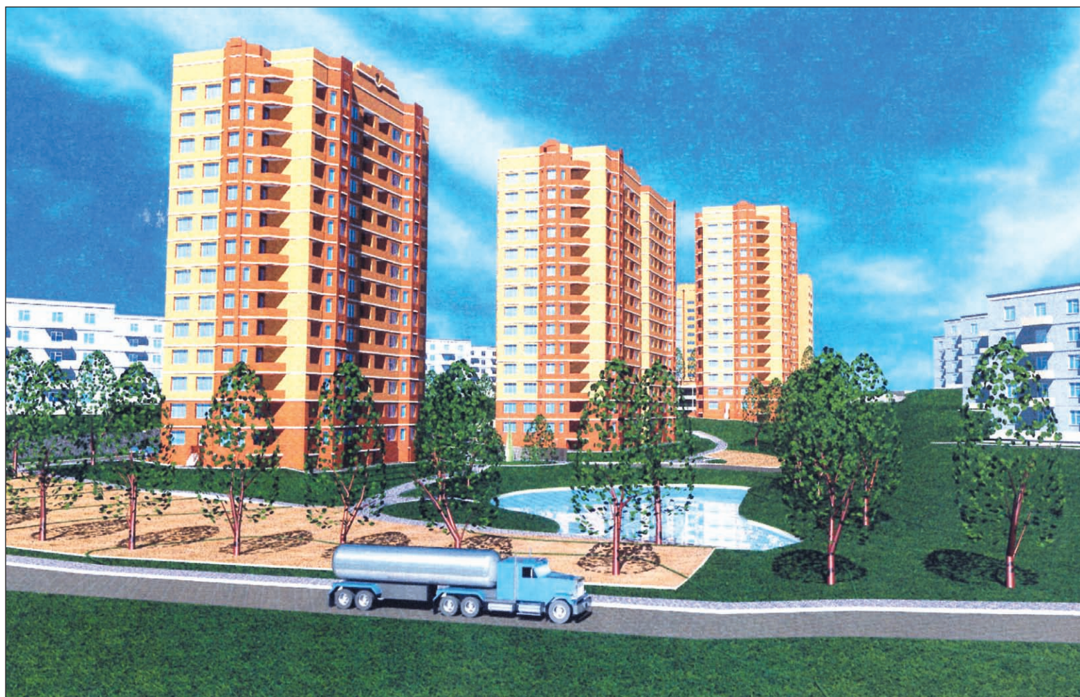
В ближайшее время в Туле в районе улицы Макаренко построят современный жилой комплекс «Кузнецкая слобода».
