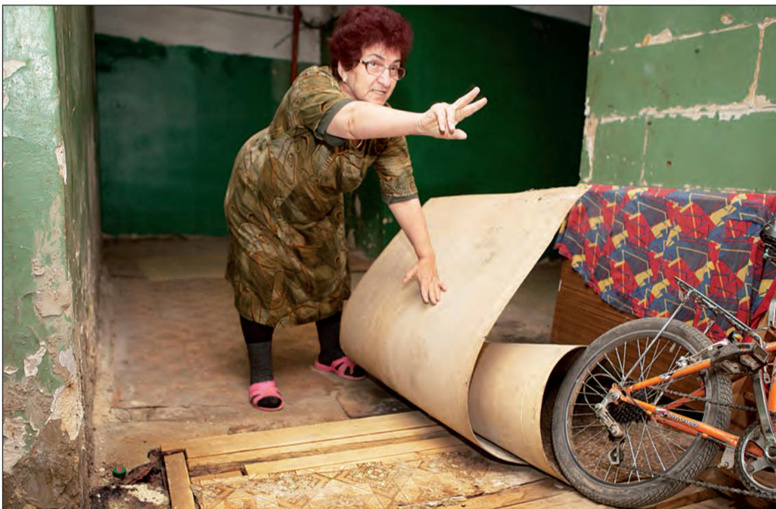
Бетонные полы на первых этажах крошатся и проваливаются от сырости, жителям приходится закрывать дыры досками и линолеумом. На фото местная жительница Сильва.
