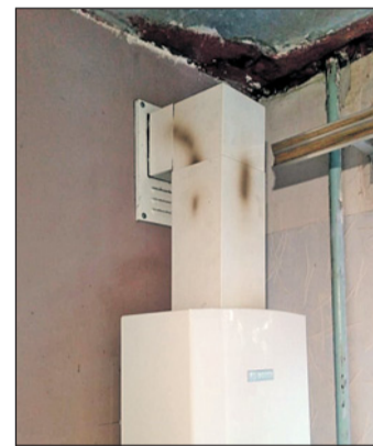
Сечение дымоотвода не соответствует требованиям завода-изготовителя и паспорта на газовое оборудование.
