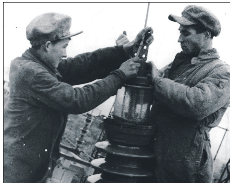
Сборка трансформатора. 1934 г.
